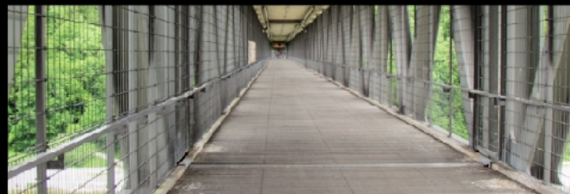
Die Bayerische Oberlandbahn (BOB) fährt über das Isartal. Unterhalb der Gleise im Fachwerkrahmen befindet sich ein kombinierter und komplett vergitterter Fuß- und Radweg.
