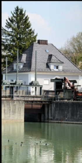
Die Isar wird durch das Wehr an der Ableitung zum Isarkanal sechs Meter aufgestaut.
