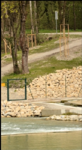
Die Fischeauf- bzw. Fischabstiegsanlage von 2012 führt um das Maschinenhaus eines Kraftwerks von 2008, in dem sich der größte Teil der Technik unter der Erde befindet.
