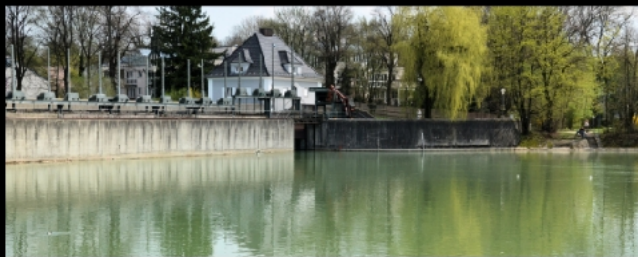
Die Isar wird durch das Wehr an der Ableitung zum Isarkanal sechs Meter aufgestaut.
