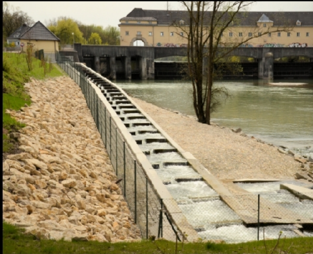
Die Fischeauf- bzw. Fischabstiegsanlage von 2012 führt um das Maschinenhaus eines Kraftwerks von 2008, in dem sich der größte Teil der Technik unter der Erde befindet.
