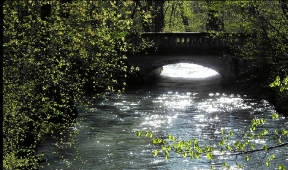
Wege am Bach, Ansichten des Oberstjägermeisterbachs von einer und auf eine Brücke
